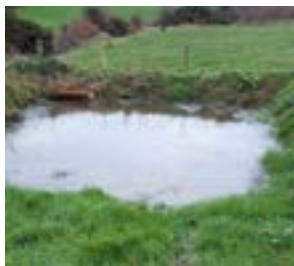
Trampa de sedimentos establecida en una granja local en Wexford
