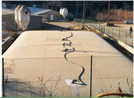
Produzione di biogas – Stoccaggio coperto del liquame e raccolta del metano
