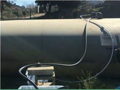
Produzione di biogas – Stoccaggio coperto del liquame e raccolta del metano
