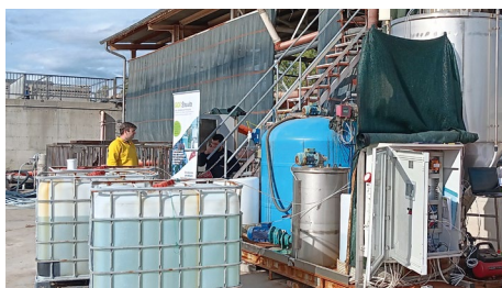
Impianto pilota di trattamento della struvite recuperata dal digestato
