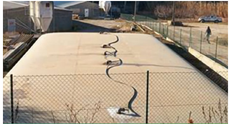
Production de biogaz – fumier stocké recouvert et captage du méthane
